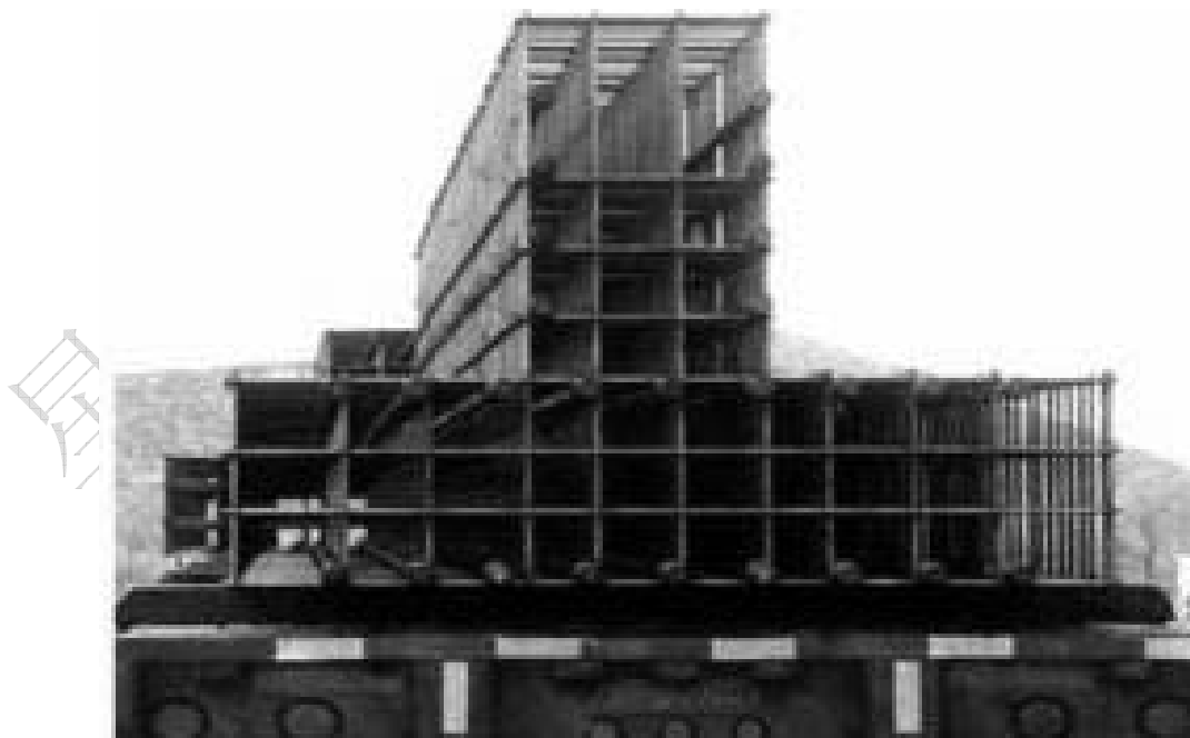
图 4.4-2 组装后倒“T”型格网箍筋钢筋笼构件
