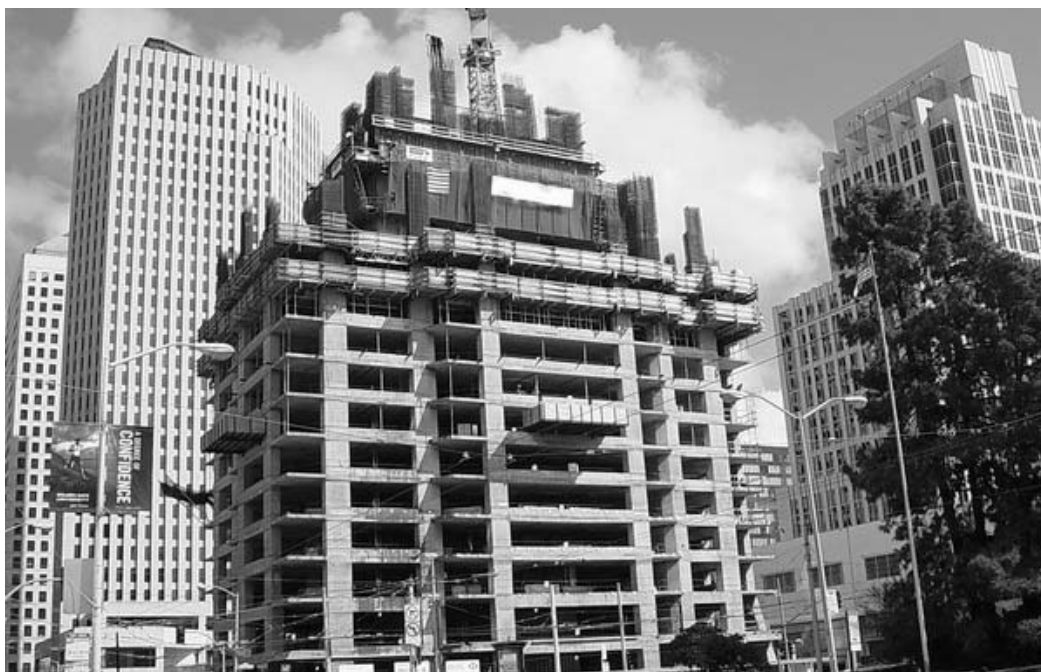
图 4.4-1 施工中的美国某 60 层大楼
