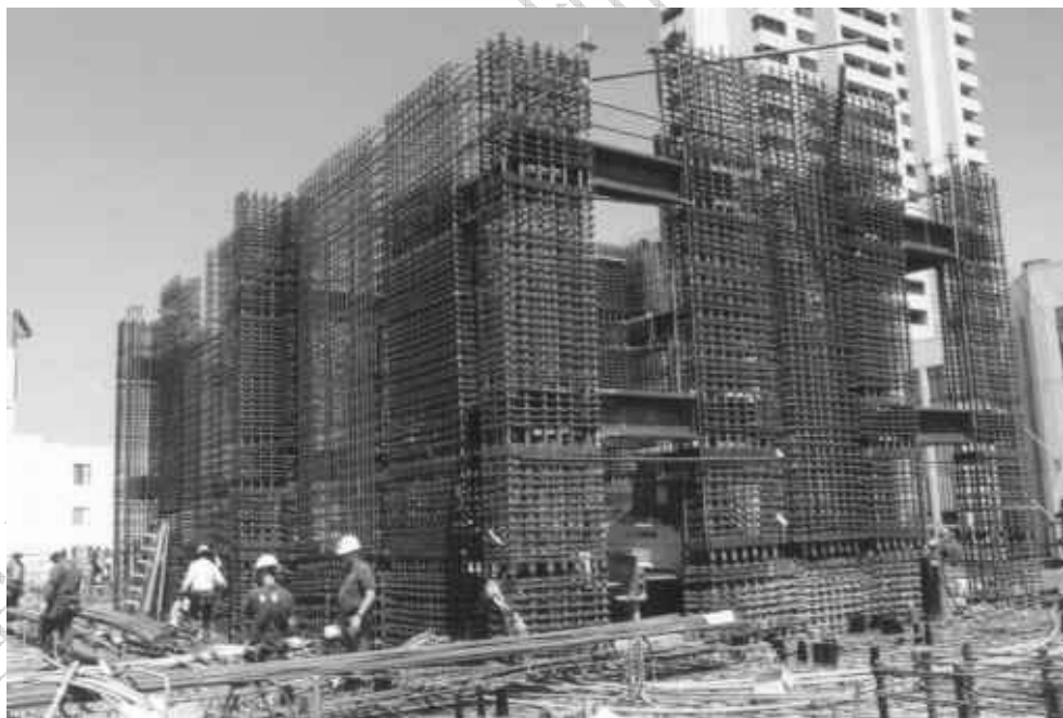
图 4.4-4 格网箍筋钢筋笼构件安装现场
